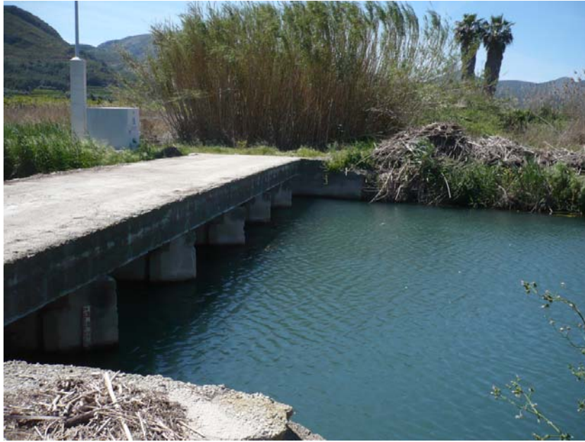
Figura 29.- Estación de telemetria de caudal en el río Racons (E-12)
